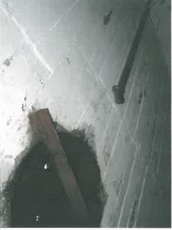
Zdj. nr 14. Odpadnięta otulina zbrojenia nadproża nad drzwiami. Korozja prętów zmniejszająca ich przekrój.
