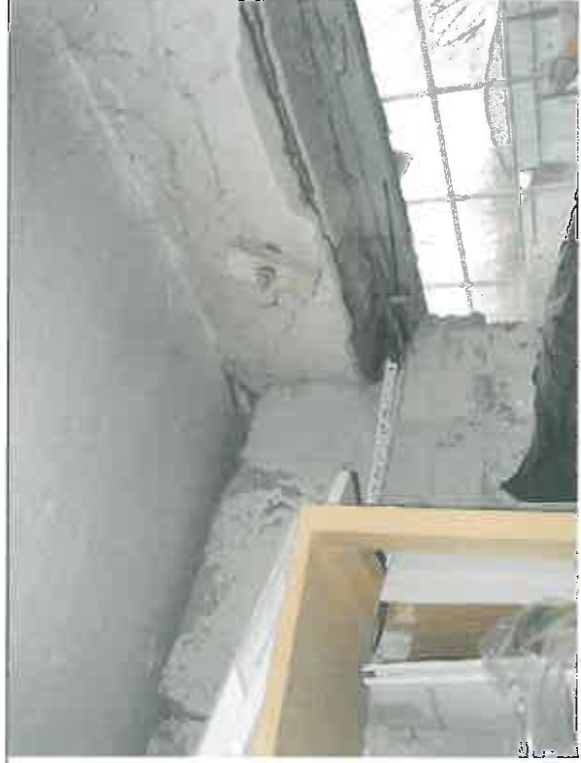
Zdj. nr 18 W magazynie farb widoczna kiamra na nadprożu okiennym oraz odstonięte pręty zbrojeniowe.
