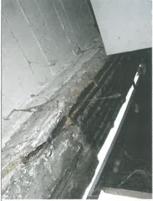
Zdj. nr 14. Odpadnięta otulina zbrojenia nadproża nad drzwiami. Korozja prętów zmniejszająca ich przekrój.
