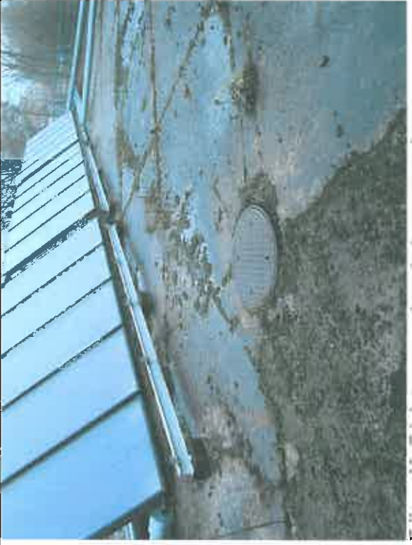
Zdj. nr 10 Fragment ściany północno-wschodniej. Widoczne ubytki i odspojenia tynku.
