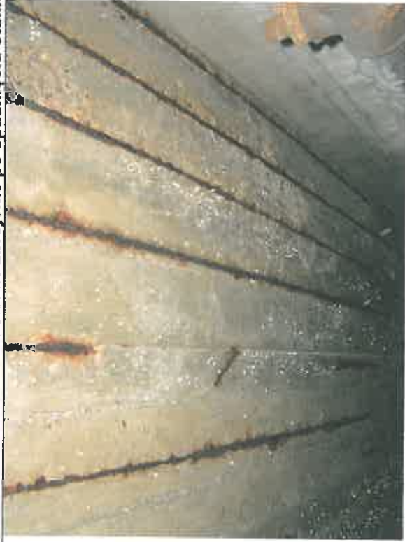
Zdj. nr 33 Uszkodzona żeliwna rura kanalizacji deszczowej. Na suficie skorodowane zbrojone po spadnięciu otuliny.
