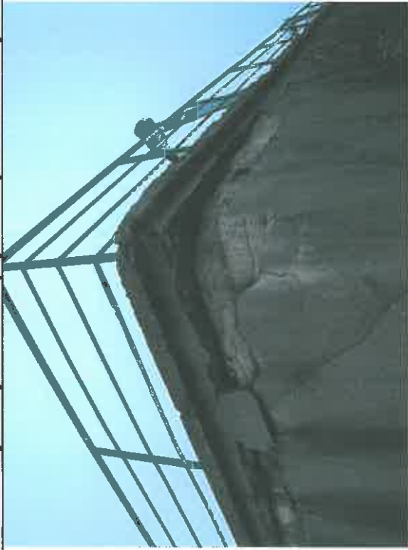
Zdjęcie nr 5 Fragment ścian południowo-wschodniej z widocznymi ubytkami i odspojeniami tynku na elewacji.
