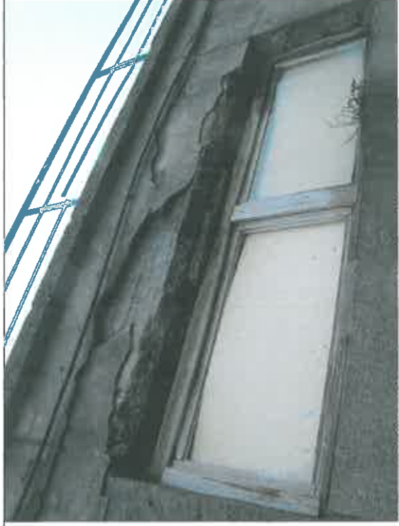
Zdjęcie nr 6 Ubytki tynku w nadprożu okiennym. Okno drewniane
