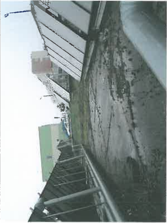
Zdj. nr 9 Widoczna dylatacja konstrukcji ściany południowo-wschodniej z ubytkami tynku.
