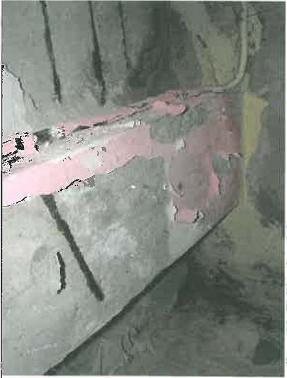
Zdj. nr 18 W magazynie farb widoczna kiamra na nadprożu okiennym oraz odstonięte pręty zbrojeniowe.
