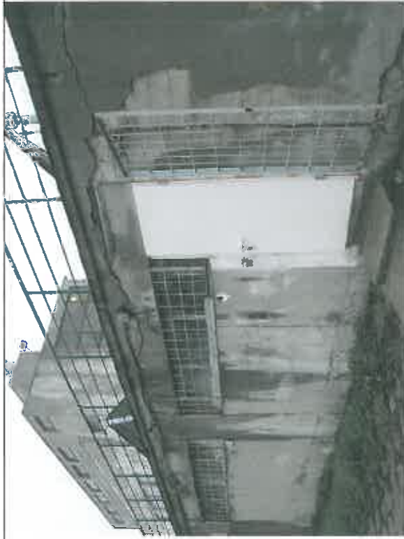
Zdjęcie nr 5 Fragment ścian południowo-wschodniej z widocznymi ubytkami i odspojeniami tynku na elewacji.
