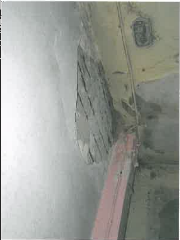
Zdj. nr 17 W miejscu przecieku odstonięte i skorodowane zbrojenie w magazynie deponyżu
