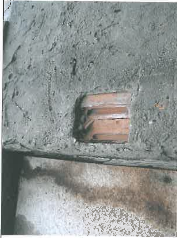
Zdj. nr 22 Sciana wewnętrzna wykonana z pustaków szceglinowych na zaprawie cementowej + obrzutka.
