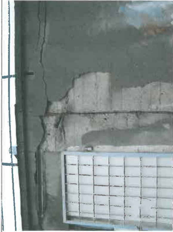
Zdj. nr 9 Widoczna dylatacja konstrukcji ściany południowo-wschodniej z ubytkami tynku.
