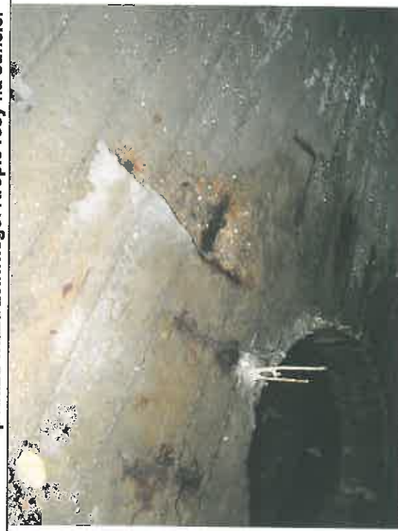
Zdj. nr 34 Kolejny przykład największej korozji zbrojenia w pobliżu włazu żeliwnego. Krople rosy na suficie.
