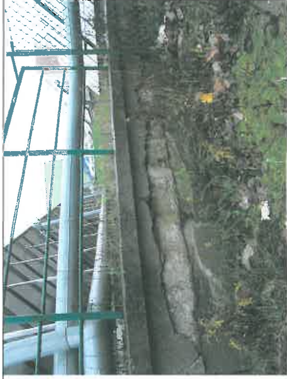
Zdj. nr 10 Fragment ściany północno-wschodniej. Widoczne ubytki i odspojenia tynku.
