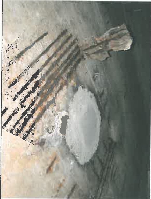
Zdj. nr 22 Sciana wewnętrzna wykonana z pustaków szceglinowych na zaprawie cementowej + obrzutka.
