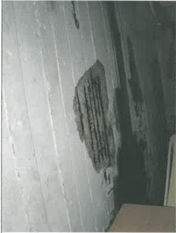
Zdj. nr 17 W miejscu przecieku odstonięte i skorodowane zbrojenie w magazynie deponyżu
