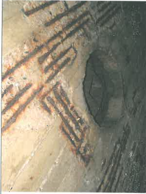
Zdj. nr 34 Kolejny przykład największej korozji zbrojenia w pobliżu włazu żeliwnego. Krople rosy na suficie.
