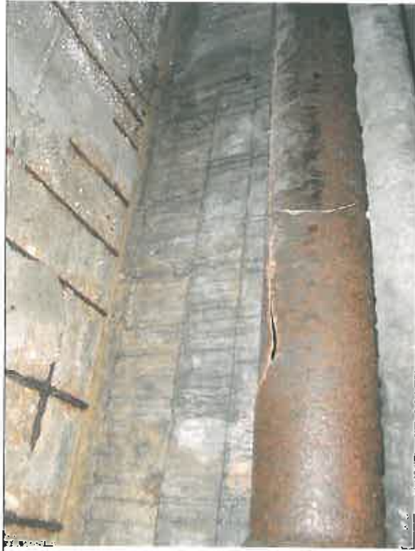
Zdj. nr 33 Uszkodzona żeliwna rura kanalizacji deszczowej. Na suficie skorodowane zbrojone po spadnięciu otuliny.
